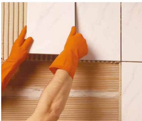
Colocación en pared de revestimiento cerámico
