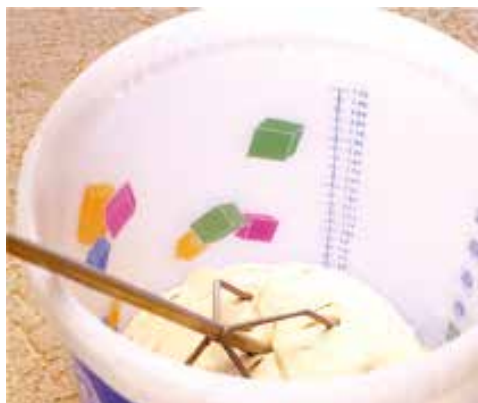
Mezcla de Mapeset C1 con agitador mecánico
